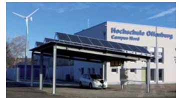
Bild 2: Reallabor INES Smart Grid – Intelligente Energienetze mit E-Fahrzeug, diversen Generatoren und KWKK
