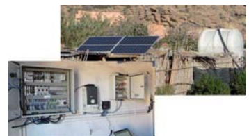
Bild 4: Inselstromversorgung für eine Pferderanch bei Agadir/Marokko im Rahmen der Greenlight-Initiative – Licht für Marokko.
