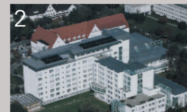
Kreiskrankenhaus Mindelheim (120 m 2 )
