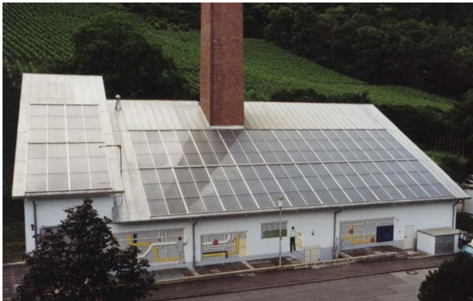
Bild 1 Ansicht der Heizzentrale des Hegau-Klinikums Singen mit in das Dach integriertem Kollektorfeld
