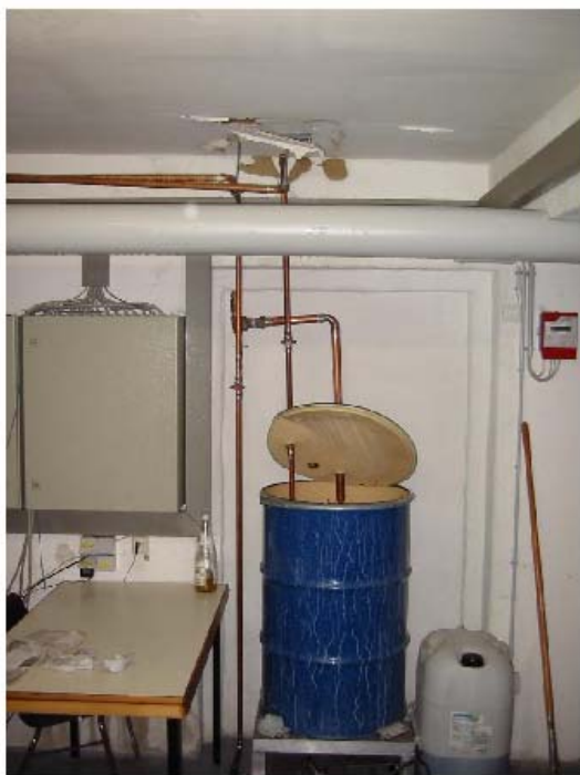
Bild 6.10 Auffangbehälter für Kollektorkreisflüssigkeit und Abblaserrohrleitungen nach Anlagenstillstand am 11.04.2003
