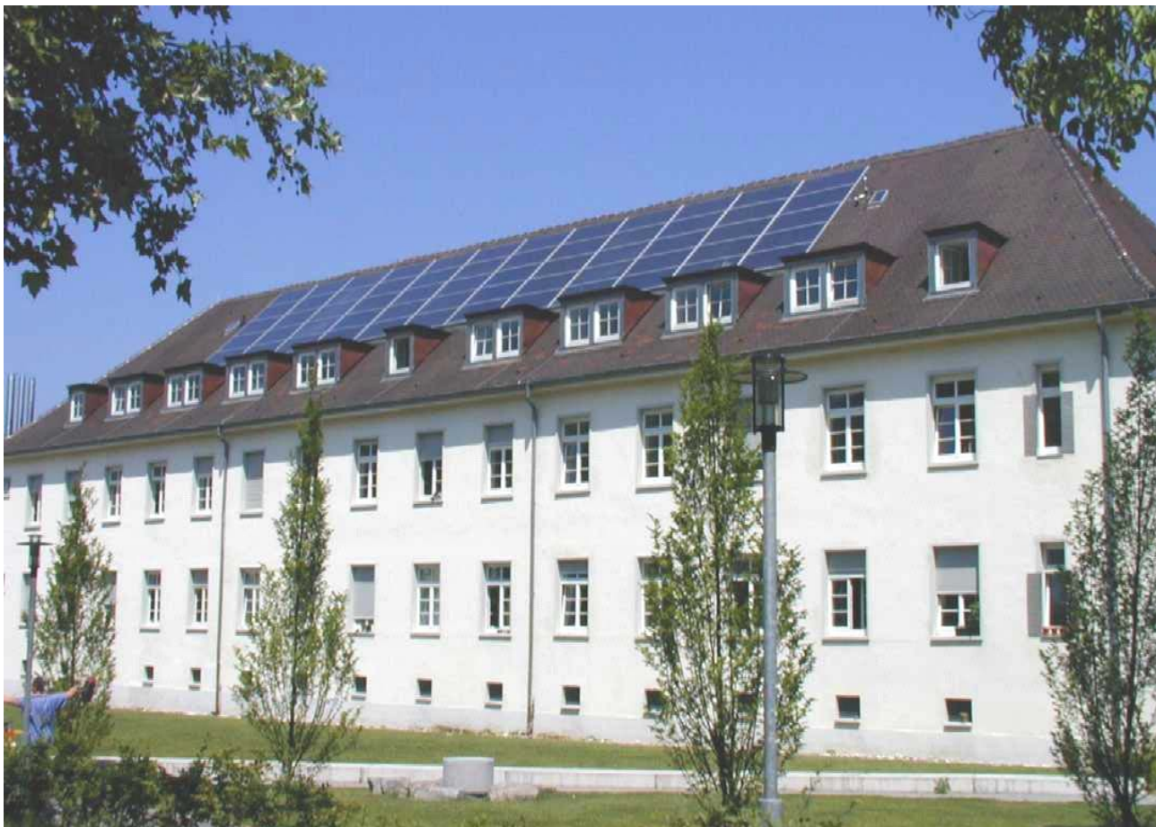
Bild 3.1 Ansicht des Kollektorfelds auf Gebäude 14 des Studentendorfs Freiburg-Vauban
