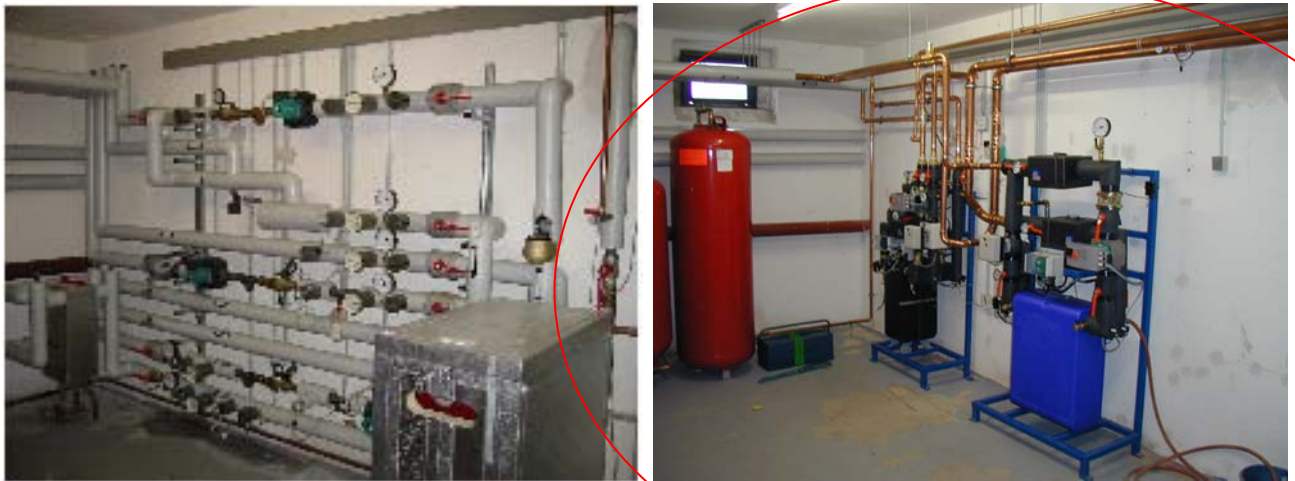
Bild 4.1 Wärmetauschergruppen und Verrohrung vor (links) und nach (rechts) dem Umbau. Jeweils links : Beladewärmetauscher (WT1). Jeweils rechts : Entladewärmetauscher (WT2).
