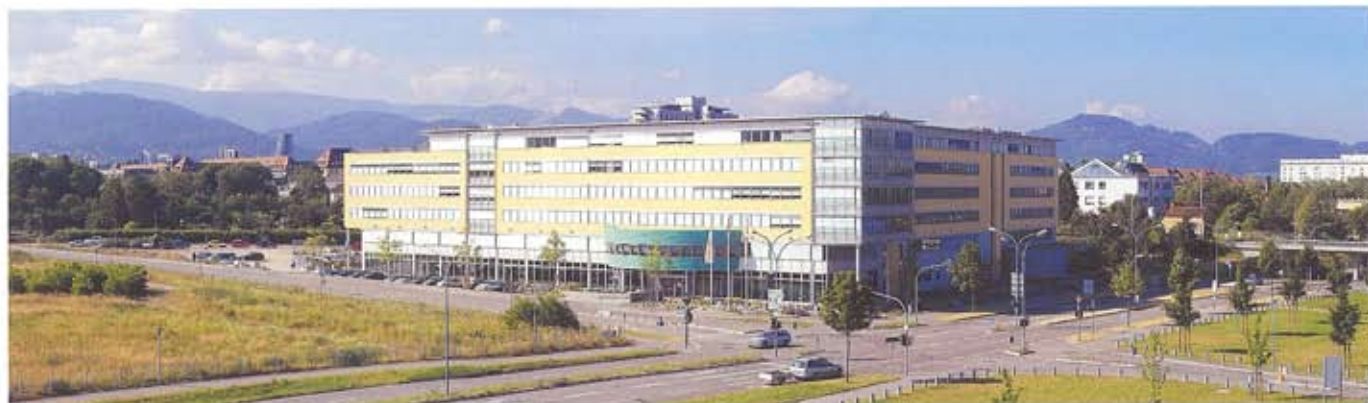
Solar Info Center Freiburg
