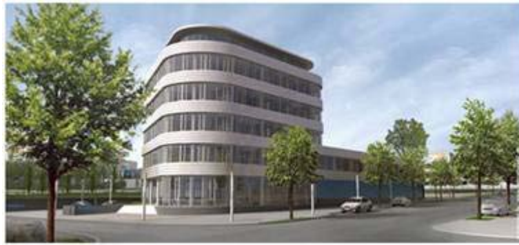
Bild 8: Der Büroneubau der Elektror GmbH in Ostfildern bei Stuttgart verfügt über eine thermische Bauteilaktivierung mit prädiktiver Steuerung.
