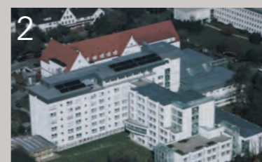
Kreiskrankenhaus Mindelheim (120 m 2 )
