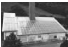
Hegau-Klinikum Singen (264 m 2 Kollektorfläche)
