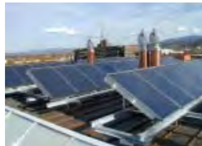
Thermische Solarkollektoren und Photovoltaik auf dem Wohngebäude in der Wilmersdorfer Straße in Freiburg
