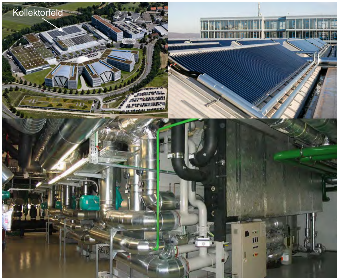
Bild 1.1: links oben: Luftaufnahme des Firmengeländes der Festo AG & Co. KG in Esslingen; rechts oben: Kollektorfeld; unten: Adsorptionskälteanlage
