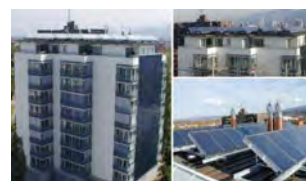
Wilmsdorferstraße Freiburg (Kollektorfläche: 228 m 2 )
