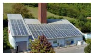
Hegau-Klinikum Singen (Kollektorfläche: 264 m 2 )
