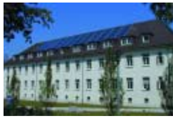
Studentendorf Freiburg-Vauban (Kollektorfläche: 143 m 2 )
