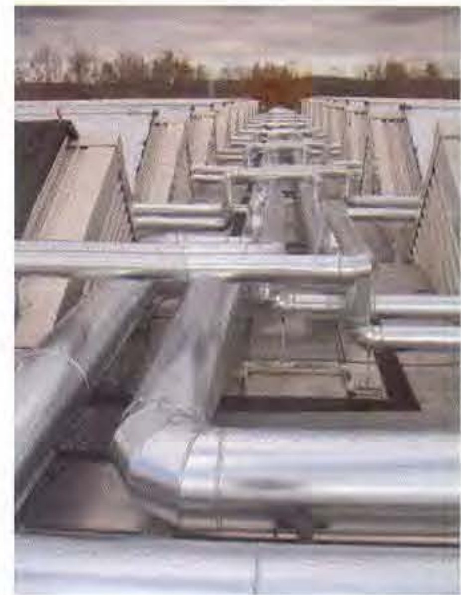
Abb. 2: Verrohrung zwischen den Kollektoren vor Inbetriebnahme. Die Kollektoren sind noch abgedeckt“
