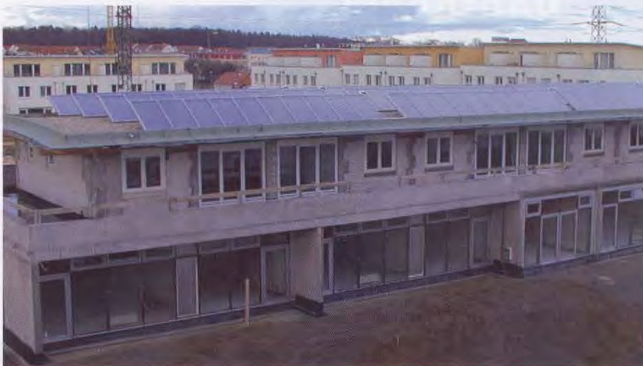
Abb. IV.7-4: Gesamtes Kollektorfeld (251 m 2 ) auf dem Flachdach des Kindergartens in Holzgerlingen
