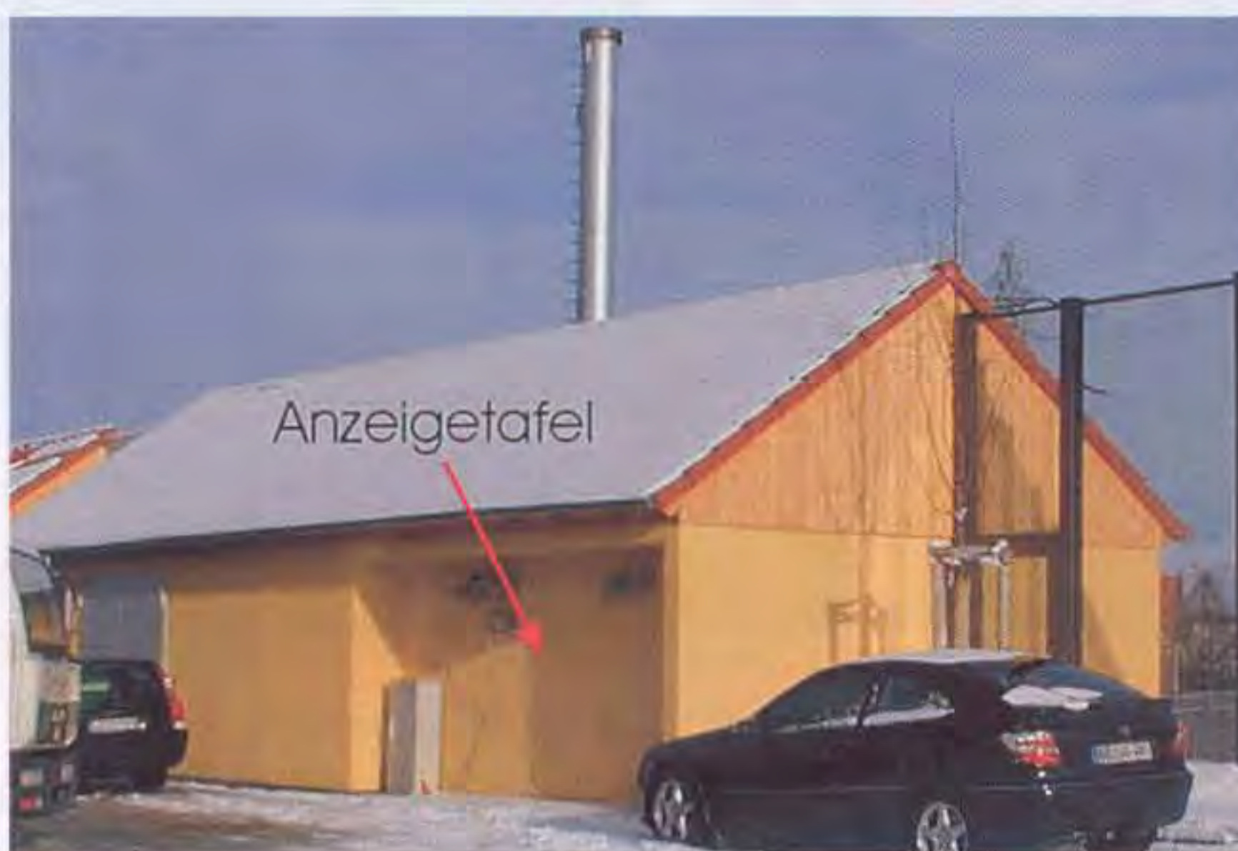
Abb. IV.7-3: Heizzentrale der Nahwärmeversorgung Baugebiet Hülben, Holzgerlingen
