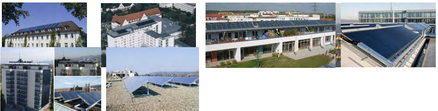
Abb. 1: obere Zeile v. l. n. r.: Studentendorf Vauban (143 m 2 ), Kreiskrankenhaus Mindelheim (120 m 2 ), Hegau-Klinikum Singen (264 m 2 ), Stadtklinik Baden-Baden (276 m 2 ); untere Zeile v.l.n.r.: Wohngebäude Wilmersdorfer Str. (228 m 2 ), Albtherme Waldbronn (226 m 2 ), Nahwärme Holzgerlingen (249 m 2 ), solare Klimatisierung Esslingen (1330 m 2 ).
