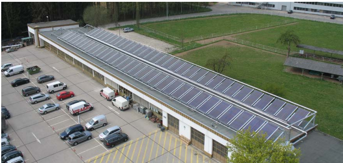
Abb. 1: Kollektorfeld der solaren Klimatisierungsanlage Rottweil
