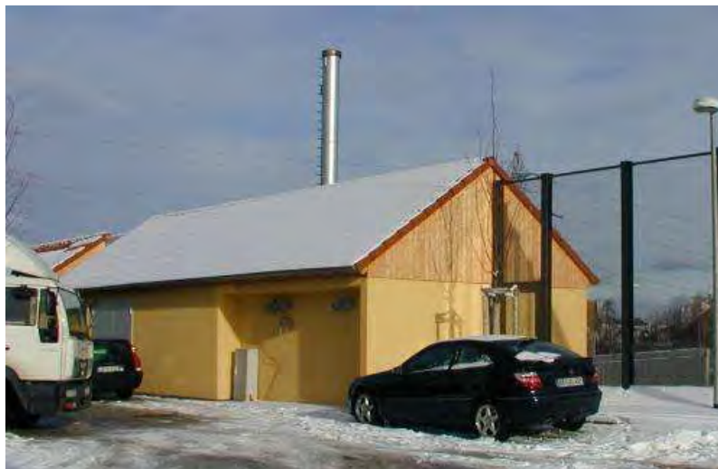
Bild 9: Heizzentrale der Nahwärmeversorgung Holzgerlingen
