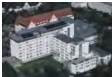
Kreiskrankenhaus Mindelheim (120 m 2 )
